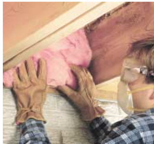
Murs de sous-sol
