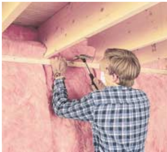
Murs du vide sanitaire
